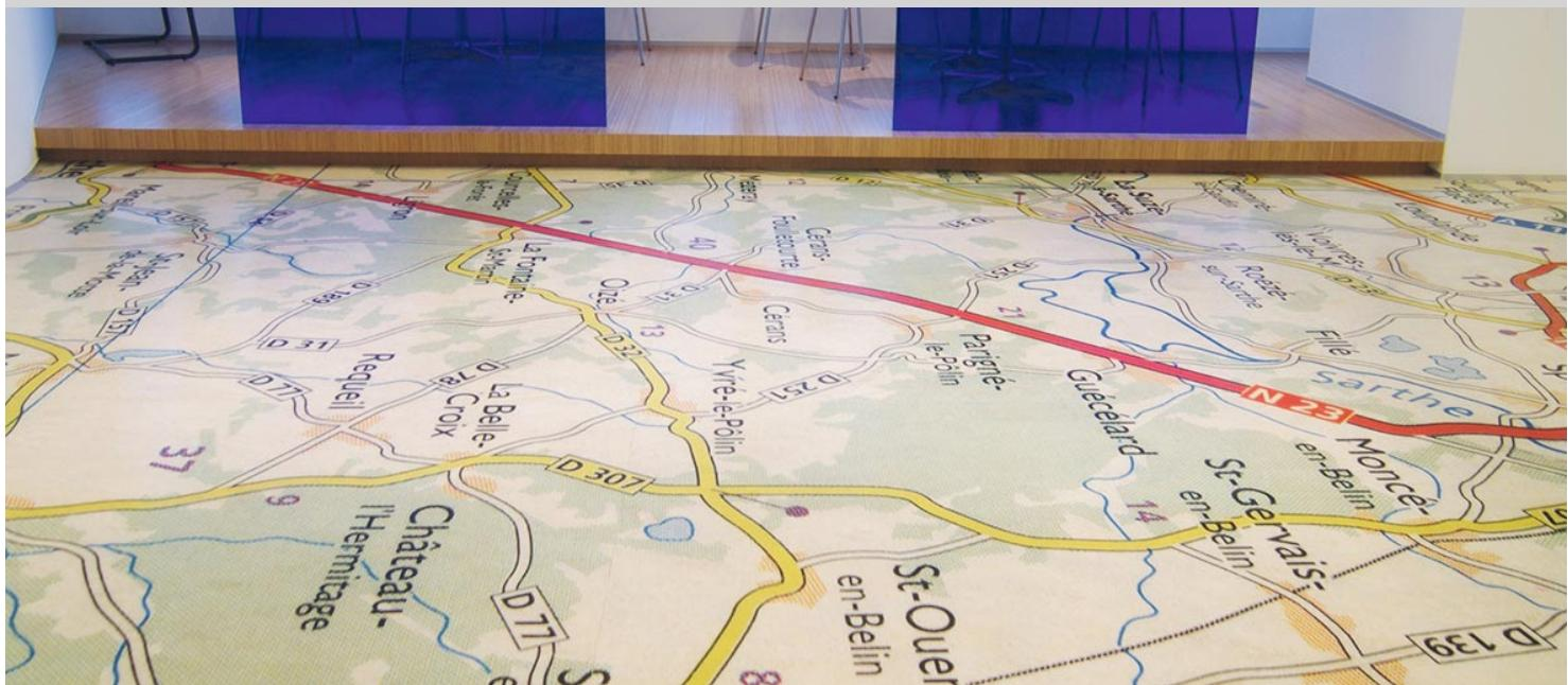
Mit der Aquajet-Technologie wird eine grenzenlose Gestaltungsfreiheit angeboten. Mit Intarsien entstehen besondere Bodenbilder, die der versierte Handwerker in die Bodenfläche einarbeitet. Linoleum bietet dafür die optimalen Voraussetzungen mit seinem großen Farbangebot für kreative Farbflächen. Egal ob eine Landkarte, verschiedene Tiere oder Pflanzen – mit Aquajet gibt es mehrere Designoptionen.
